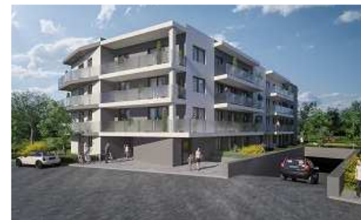
Budynek przy ulicy Budowlanych w Górze Kalwarii
