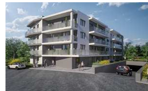
Budynek przy ulicy Budowlanych w Górze Kalwarii
