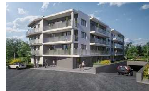
Budynek przy ulicy Budowlanych w Górze Kalwarii
